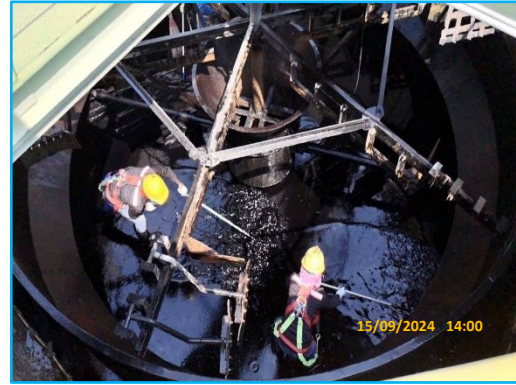
ภาพที่ 2.22 การขุดลอกตะกอนบริเวณบ่อกักน้ำทิ้ง ของโครงการฯ
