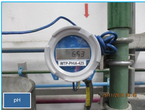
ภาพที่ 2.20 เครื่องตรวจวัดคุณภาพน้ำอัตโนมัติ
