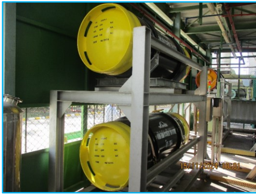
ภาพที่ 2.41 ถังเก็บแอมโมเนียทรงกระบอกแบบปิด
