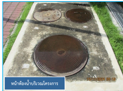
ภาพที่ 2.15 บ่อเกรอะรวบรวมน้ำเสียจากห้องน้ำ-ห้องส้วม บริเวณต่าง ๆ
