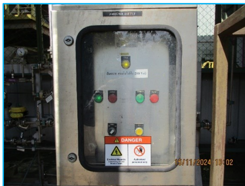
ภาพที่ 2.3 ระบบควบคุม Ammonia slip ของปล่อง SCR
