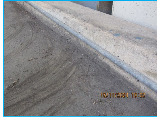
ภาพที่ 2.45 เชื้อนป้องกันการหกรั่วไหลรอบพื้นที่จัดเก็บถังแอมโมเนีย
