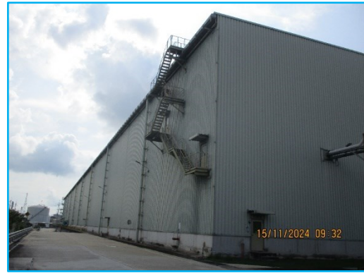
ภาพที่ 2.9 การออกแบบอาคารเป็นอาคารปิด เพื่อป้องกันเสียงดังออกสู่ภายนอกโครงการฯ
