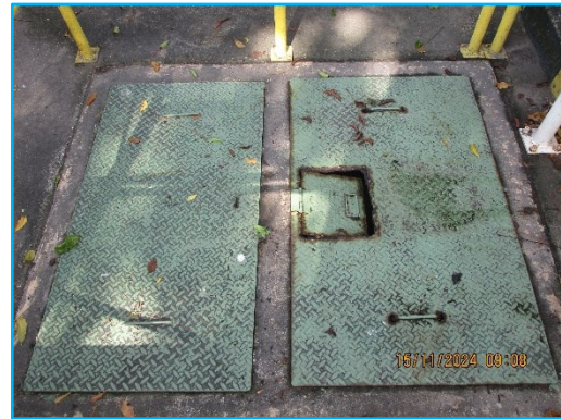
ภาพที่ 2.19 บ่อตรวจสอบคุณภาพน้ำ (Inspection pit)
