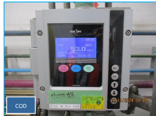
ภาพที่ 2.20 เครื่องตรวจวัดคุณภาพน้ำอัตโนมัติ
