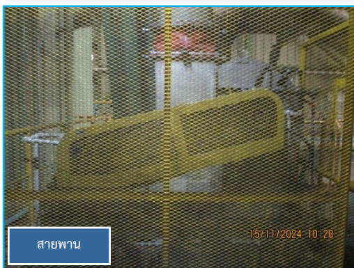
ภาพที่ 2.5 ระบบสายพานและมอเตอร์ต่าง ๆ ของระบบบำบัดมลพิษทางอากาศ
