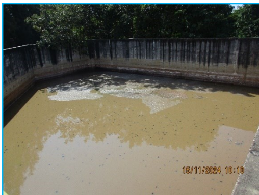
ภาพที่ 2.16 บ่อพักน้ำทิ้งฉุกเฉิน (Emergency pond) ขนาด 3,500 ลูกบาศก์เมตร
