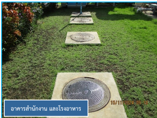
ภาพที่ 2.15 บ่อเกรอะรวบรวมน้ำเสียจากห้องน้ำ-ห้องส้วม บริเวณต่าง ๆ
