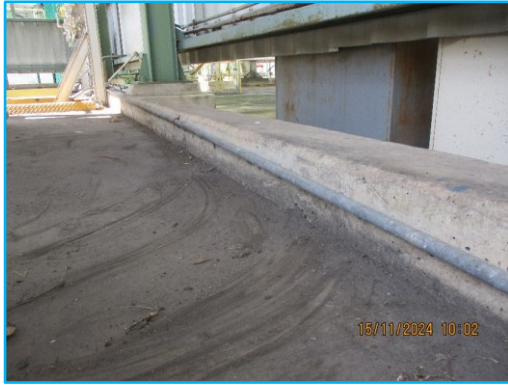
ภาพที่ 2.45 เชื้อนป้องกันการหกรั่วไหลรอบพื้นที่จัดเก็บถังแอมโมเนีย
