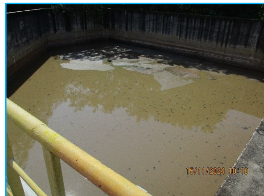
ภาพที่ 2.16 บ่อพักน้ำทิ้งฉุกเฉิน (Emergency pond) ขนาด 3,500 ลูกบาศก์เมตร
