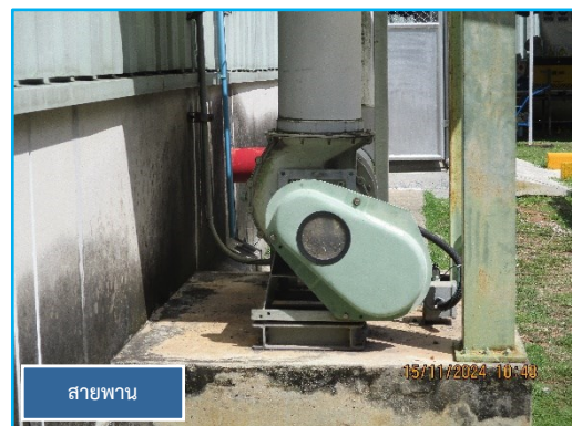
ภาพที่ 2.5 ระบบสายพานและมอเตอร์ต่าง ๆ ของระบบบำบัดมลพิษทางอากาศ
