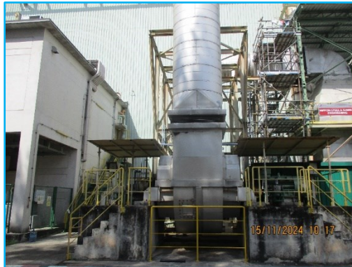
ภาพที่ 2.1 ระบบบำบัดมลพิษทางอากาศแบบ Selective Catalytic Reduction (SCR)
