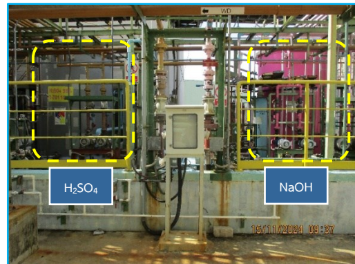
ภาพที่ 2.40 ถังจัดเก็บสารเคมี NaOH และ H 2 SO 4
