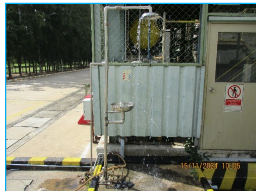
ภาพที่ 2.48 ฝักบัวฉุกเฉินและอ่างล้างตาฉุกเฉิน ในบริเวณพื้นที่ปฏิบัติงานเกี่ยวกับ แอมโมเนีย
