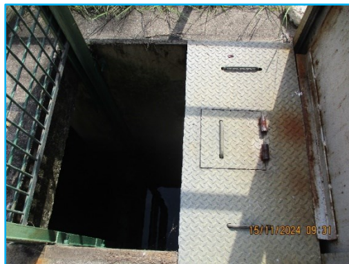
ภาพที่ 2.25 บ่อดักตะกอนและตะแกรงดักขยะมูลฝอย
